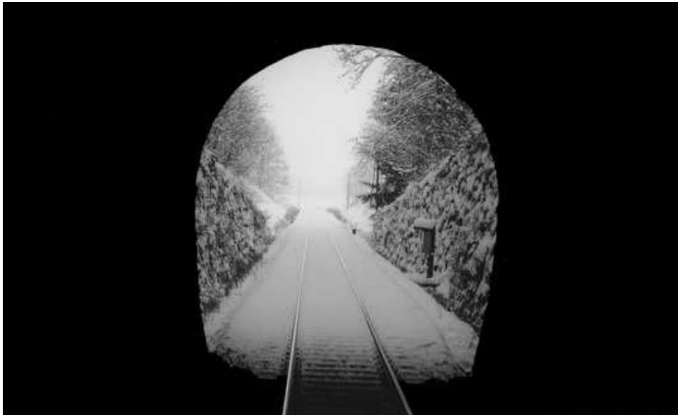
Ausfahrt aus dem Loßburger Tunnel in Richtung Freudenstadt - kurz vor dem Scheitelpunkt
